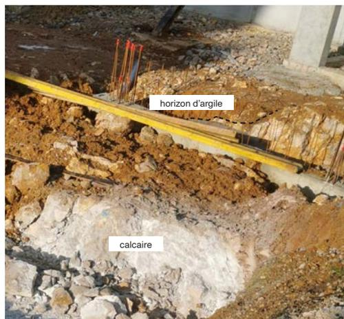
Sols naturels - Chantier de construction à l'angle de la rue de Dole et de la rue Charles Dornier. Ici, l'horizon d'argile de décalcification visible est une couche résiduelle de ce qui était naturellement en place ; cet horizon a largement été décapé, sur plusieurs mètres, dans le cadre des travaux.
